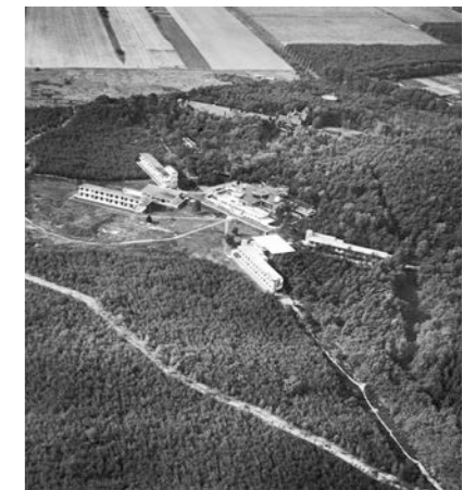
Luchtfoto van het centrale deel van Landgoed Zonnestraal met het hoofdgebouw geflankeerd door paviljoenen.
